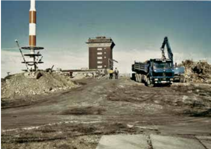
Abb. 10 und 11: Um den Transportaufwand zu minimieren, wurden Beton und Steine mit Hilfe einer Brecheranlage direkt auf dem Brocken zerkleinert (Fotos: G. Karste).
