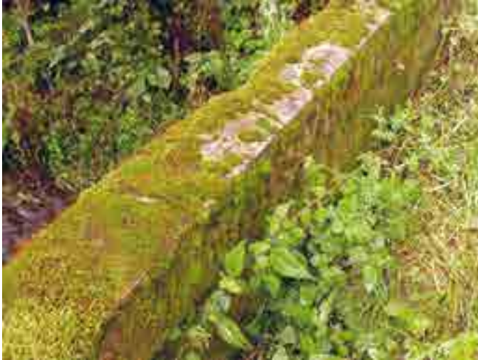
Beton-Brücke über die Wormke am Steuerkopf September 2007
